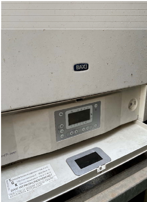
Foto n. 3 – Caldaia a metano esistente
