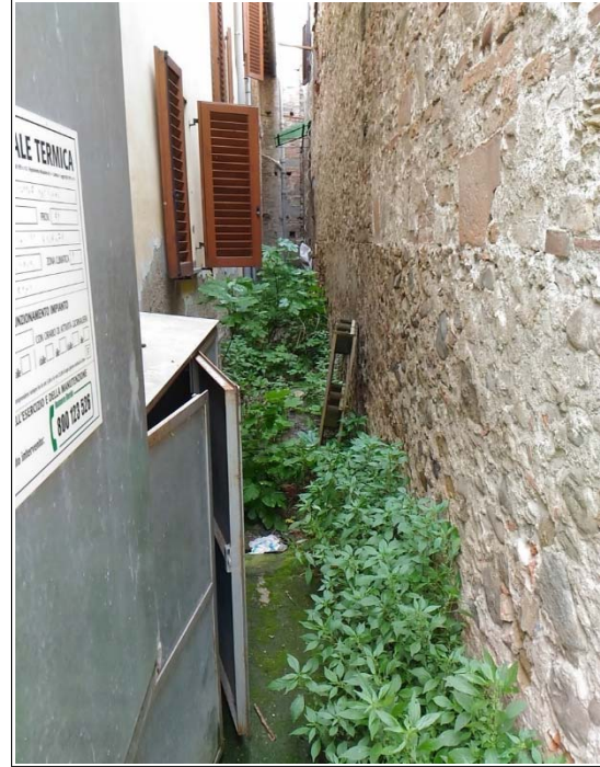
Foto n.1-Caldaia nell'intercapedine ovest Foto n. 2 – Cassone contenente la caldaia
