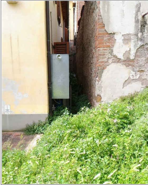
Foto n.1-Caldaia nell'intercapedine ovest Foto n. 2 – Cassone contenente la caldaia
