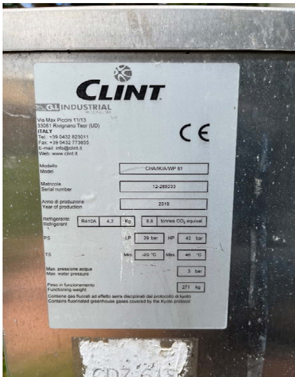
Foto n. 5 – Etichetta Unita est. Pdc esist.
