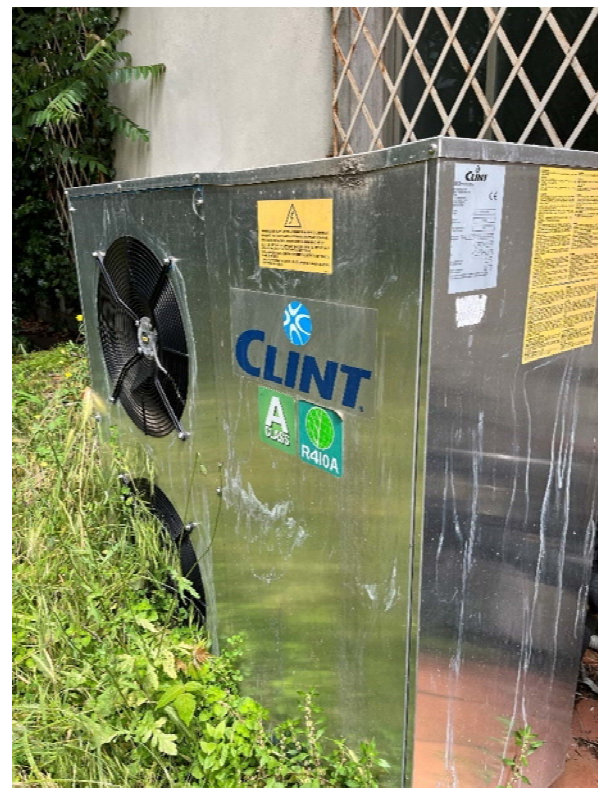
Foto n. 4 – Unità Esterna PdC esistente
